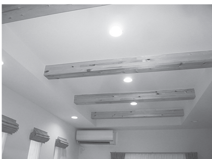
▲梁がそのままアクセントになった折上天井
